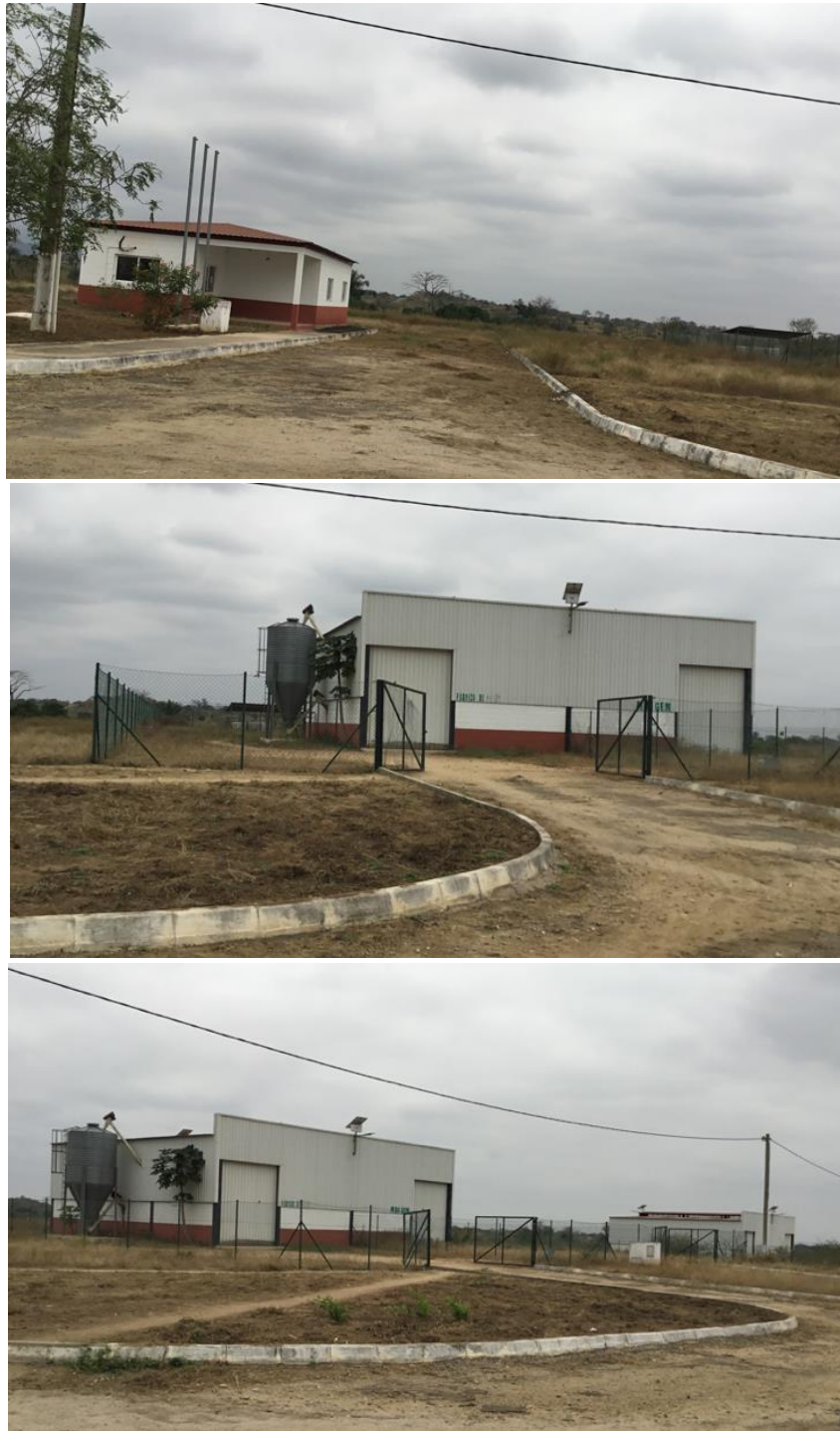
Fotografias das infra-estruturas do PIR da Canjala obtidas no terreno (2023)
